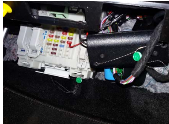
Caja de conexiones
